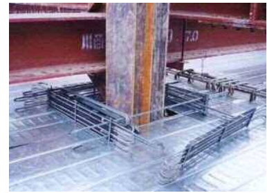
フラットデッキ (構台)
