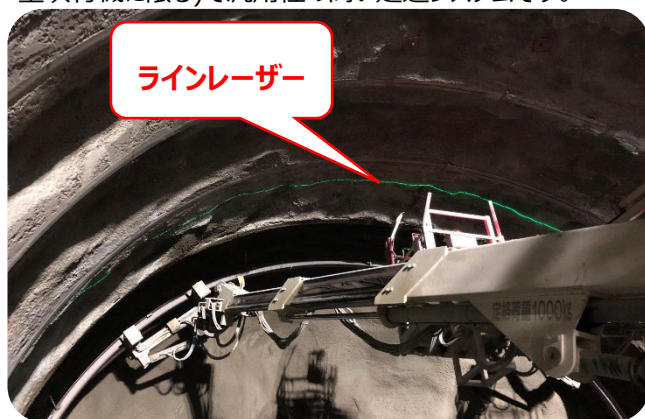
②ラインレーザーによる建込位置ガイダンス
