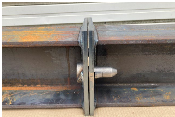
〈支保工連結状況〉
