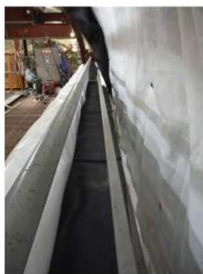
②専用台車設置
