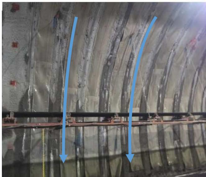
ホースや排水マット等の裏面排水材を用い、裏面排水工まで線上に排水材を配置して導水します。
