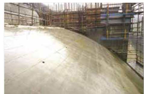
◀ ダム本体工事
