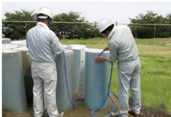
2.給水施工状況
