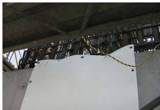
3.取付施工状況
