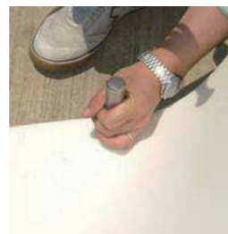
ポンチにて穴開け加工
