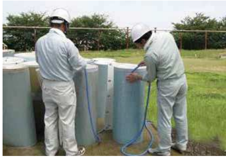
2.給水施工状況
