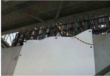
3.取付施工状況
