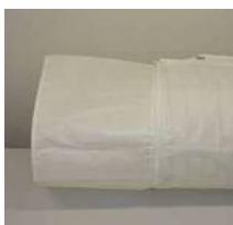
SAダクト、コネクター接続
