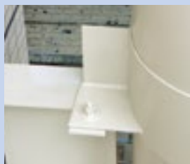
支持金物③ (鉄骨ガセットに固定)
