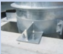
支持金物① (躯体にアンカー固定)
