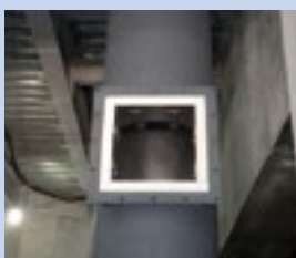
横引き煙道接続フランジ
