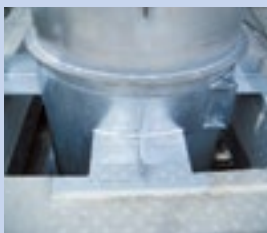
支持金物② (埋込み金物に溶接)
