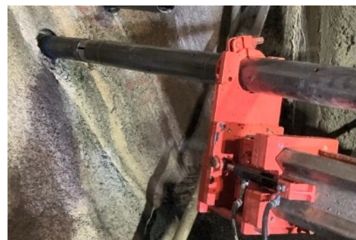
図-8 現場試験施工状況
