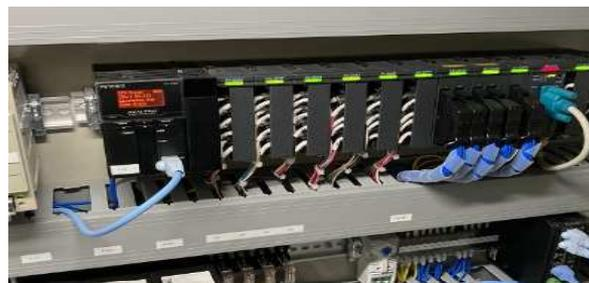
図-4 注入機 制御盤内PLC設置状況
