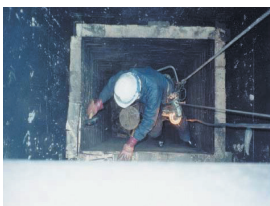
レンガ撤去中
