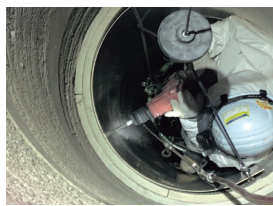
ライニング材直貼り
