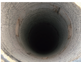
既存ライニング材撤去
