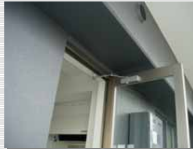
屋外側排気口(ベランダから撮影)
