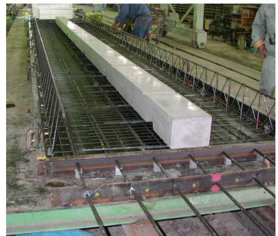
写真1 リップ付きPC板の製作状況
