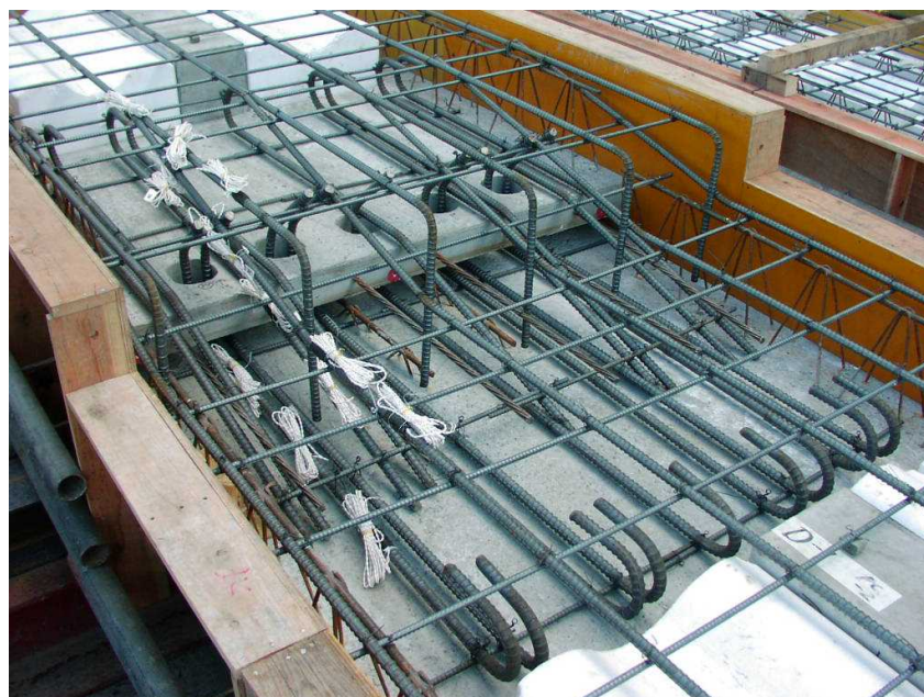
写真2 段差部の配筋状況
